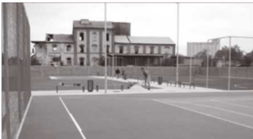
Športový areál Tryskáč tesne pred dokončením.
